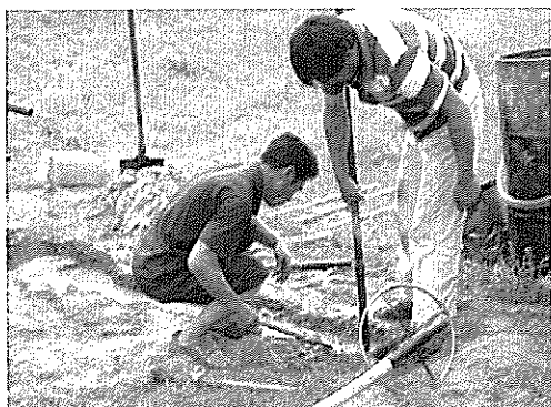
地区補助金ポンプ井戸建設事業費を使って 現地では早速井戸掘りをしていました。 ここでは15メートルで水が出る
