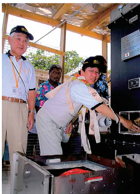
焼却炉火入れ式 (レブカ病院)
