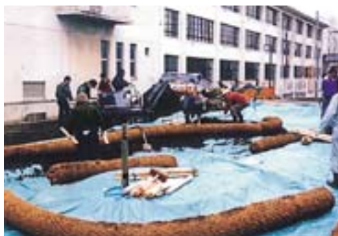
遮水シート張りと湿地ロール据付
